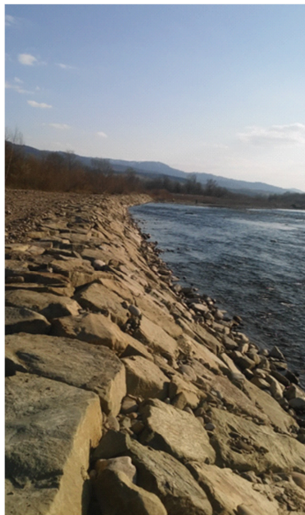
FOT. 2. Najbardziej spektakularnie uregulowany brzeg rzeki w okolicach odcinka Soł.9, wraz z zerwaną warstwą zielną.
