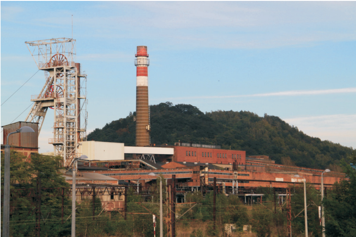
Fig. 2. The "Dębieńsko" mine in Czerwionka -Leszczyny
