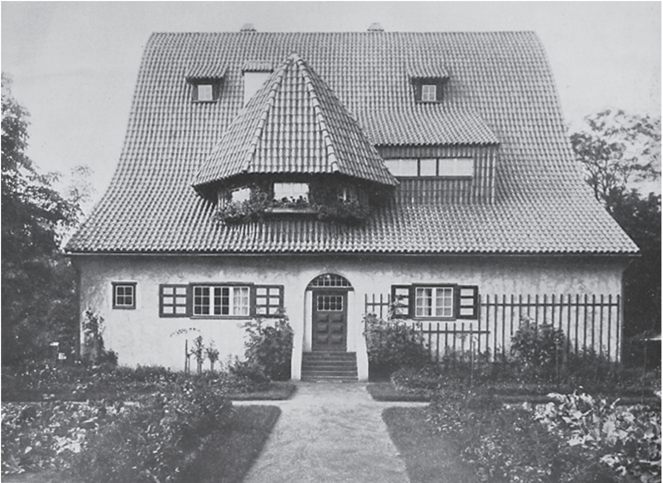
fig. 6 H. Poelzig, Einfamilienhaus. Photo: M. Markowska, 2020, after: K. Masner, Das Einfamilienhaus des Kunstgewerbevereins für Breslau und Provinz Schlesien auf der Ausstellung für Handwerk und Kunstgewerbe in Breslau 1904 , Berlin 1905, p. 23
