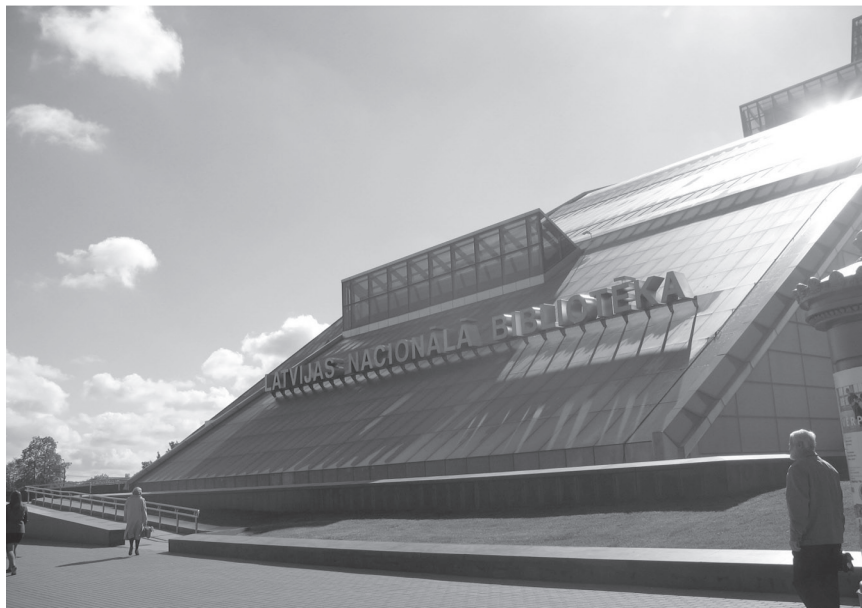
Fot. 3. Gmach Biblioteki Narodowej Łotwy
