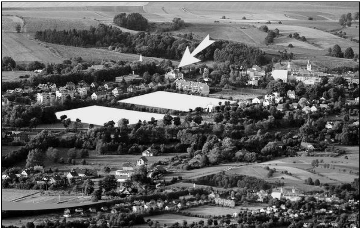
Ryc. 8. Radków – tereny przeznaczone na projekt osiedla dla seniorów. Fig. 8. Radków – housing estate for senior citizens building land. Źródło/Source: ngo.pl.
