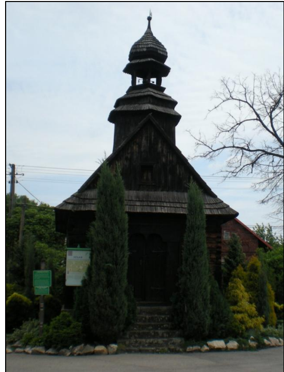
Fot. 4. Kaplica Matki Boskiej Różańcowej w Bukowie z XVIII w. – reper do wyznaczania stanu wód w czasie powodzi.
