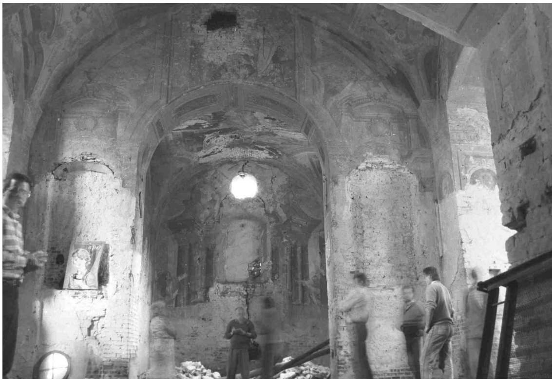
31. Joseph Prechtl (atrybucja), retabulum ołtarza głównego, malowidło ściennie, kościół pw. św. Michała Archanioła w Hołobach, ok. 1785. Fot. Grażyna Ruszczyk, 1993, zbiory IS PAN, Warszawa
