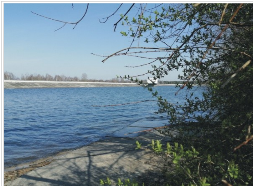
Fot. 3. Widok zapory czołowej zbiornika Poraj z zatoki północno-zachodniej (fot. A. Magiera).
