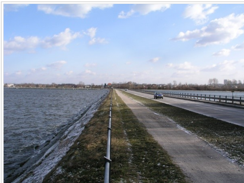
Fot. 3. Obwałowania z drogą między akwenem głównym Zbiornika Rybnickiego (po lewej) i Zalewem Orzepowickim (po prawej) (fot. M. Rzętała).
