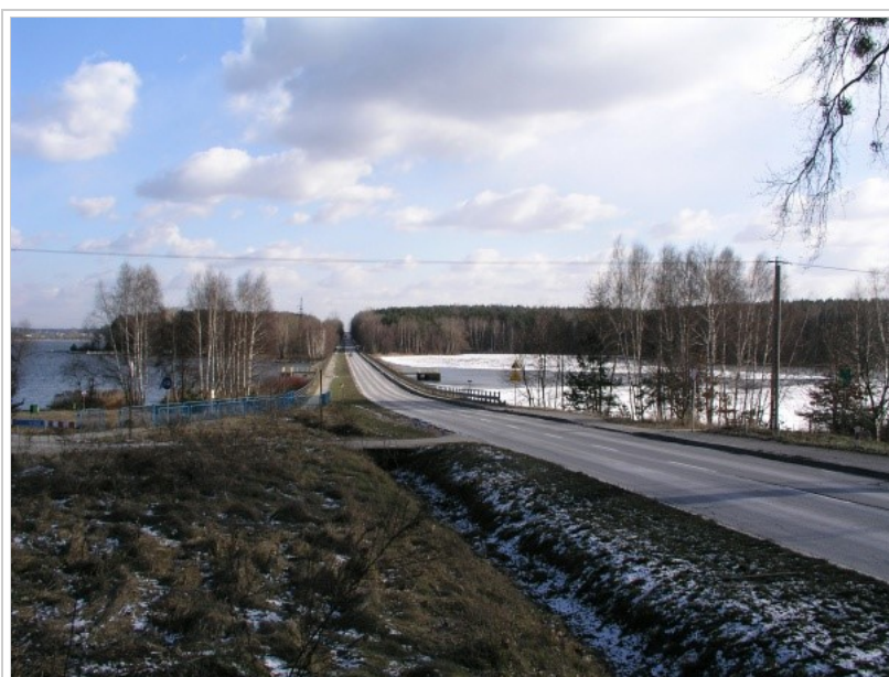
Fot. 4. Wolny od lodu akwen główny Zbiornika Rybnickiego i jego zalew boczny Gzel z pokrywą lodową (fot. M. Rzętała).
