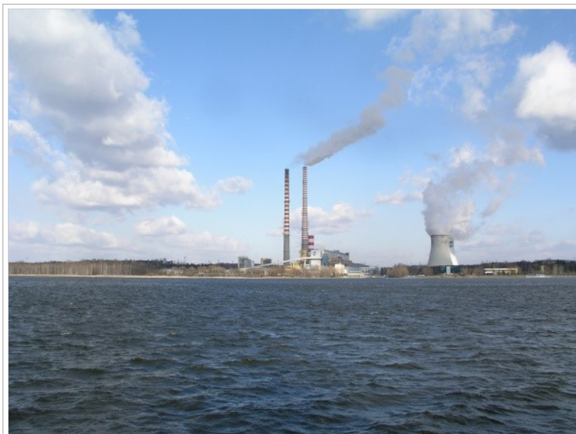
Fot. 1. Elektrownia nad Zbiornikiem Rybnickim (fot. M. Rzętała).
