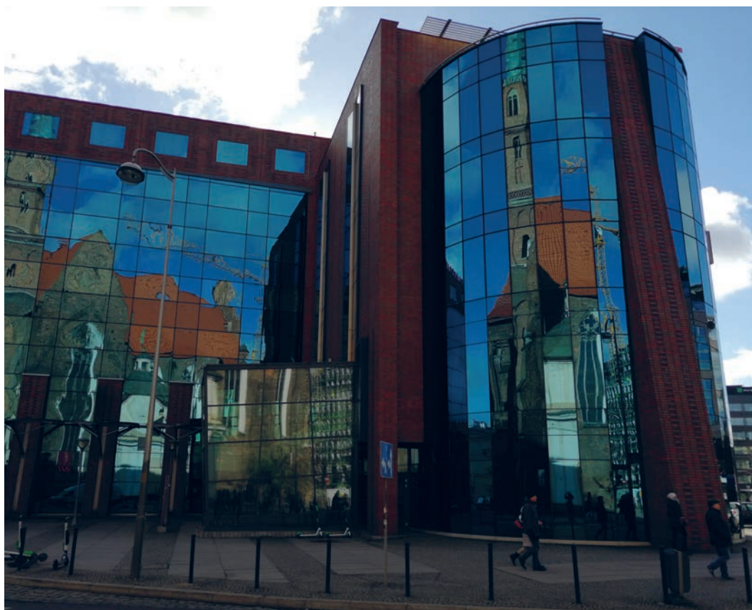
Il. 7. Galeria Dominikańska z hotelem Mercure-Panorama — szkło i cegła klinkierowa, 2002, Studio EL, Wrocław. Fot. K. Tomczak
