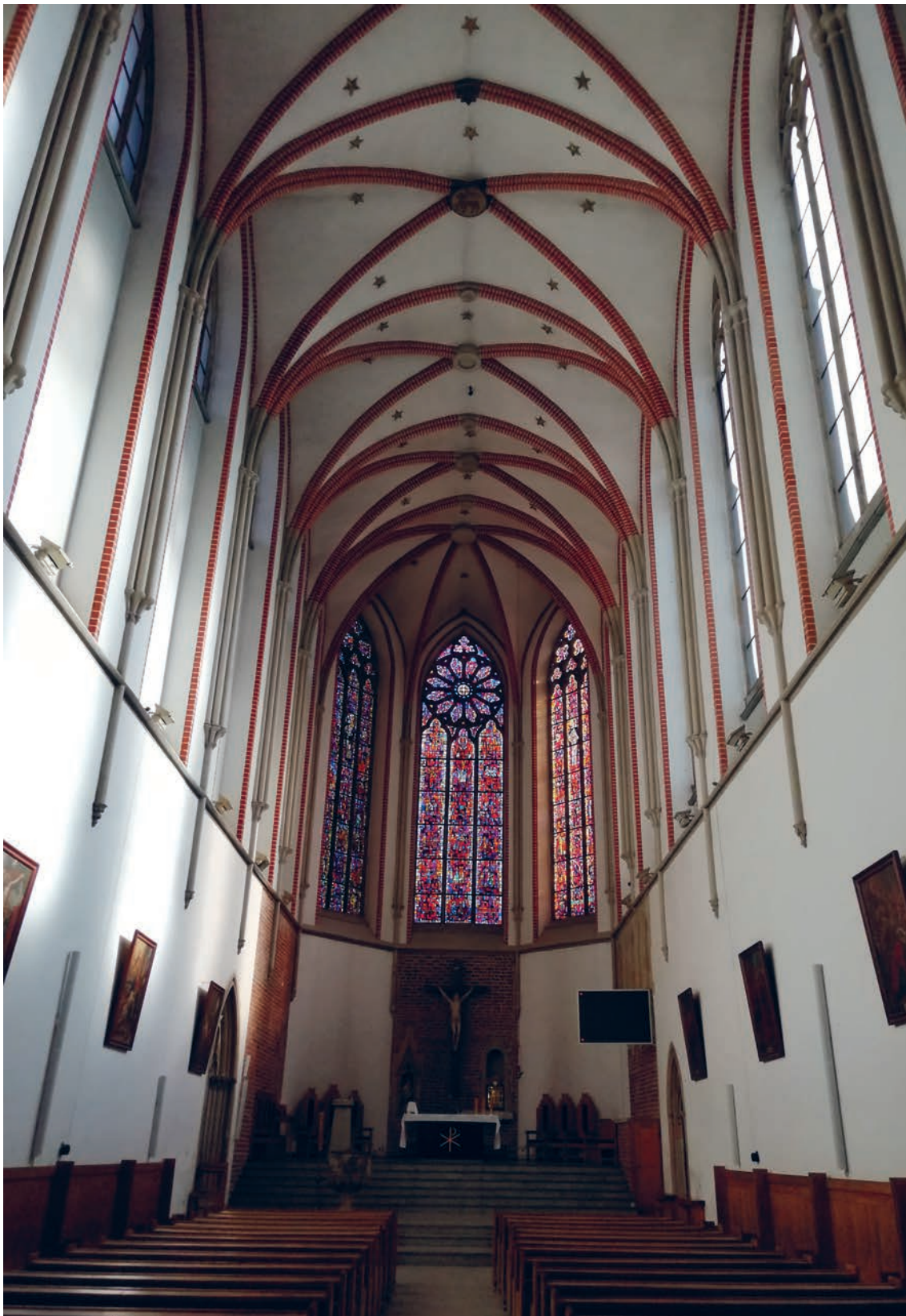
Il. 3. Kościół pw. św. Wojciecha, sklepienie krzyżowo-żebrowe, chór, XII wiek, Wrocław. Fot. K. Tomczak
