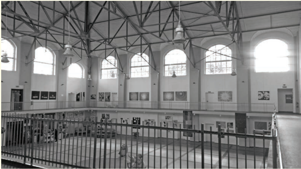
Fot. 17. Szyb Wilson, Katowice (2017, A. Kuncce)
