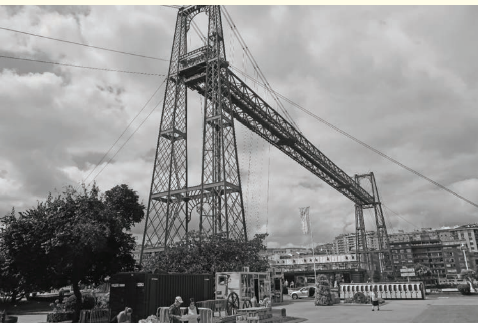
Fot. 19. Bilbao (2017, A. Kuncce)
