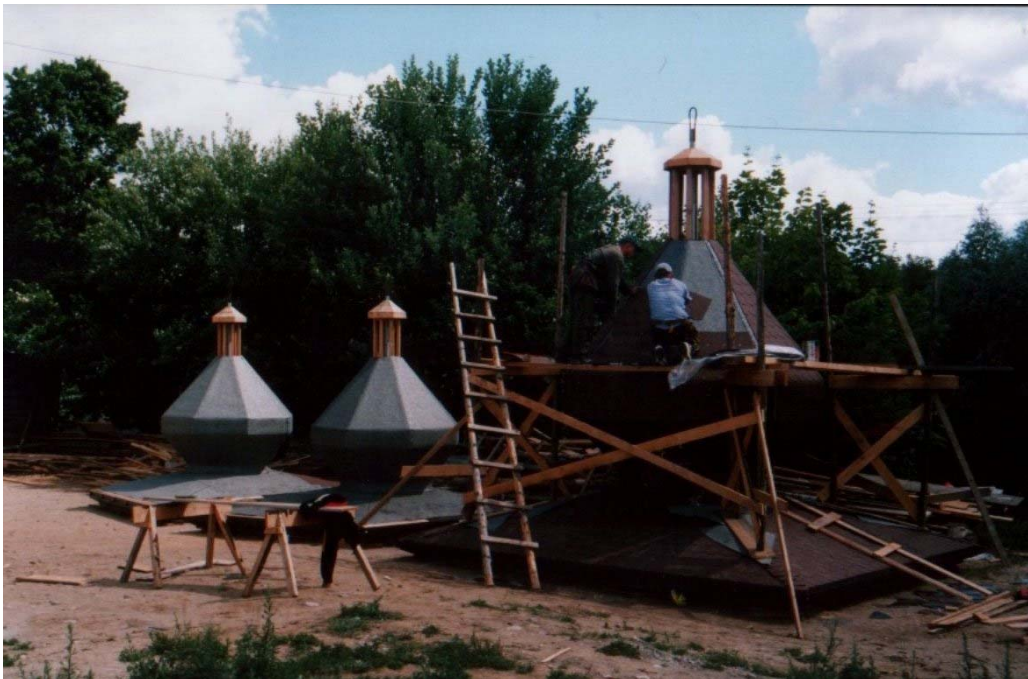
Foto. 3. Kruklanki. Trwają prace przy zwieńczeniu budynku – krycie bań cerkiewnych (zdjęcie pochodzące z badań własnych).
